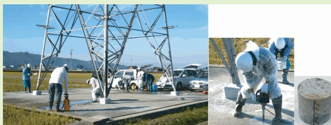
図 3 被雷鉄塔での試料採取。右は 1 インチ径の試料
